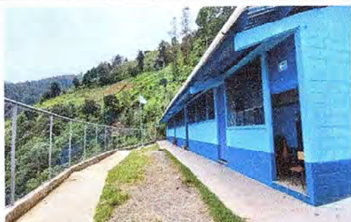
Foto 3: Panorama actual de la escuela con los trabajos de remozamiento realizados, instalación de canales y bajadas de agua, sustitución de puertas de metal y aplicación de pintura en paredes exteriores e interiores.
