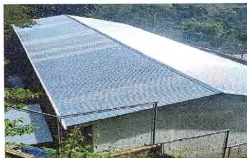
Foto 2: Vista exterior del módulo con la instalación de láminas troqueladas calibre 26.
