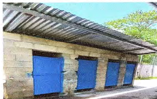
Foto 4: Instalación de nuevas puertas de metal en los servicios sanitarios.
