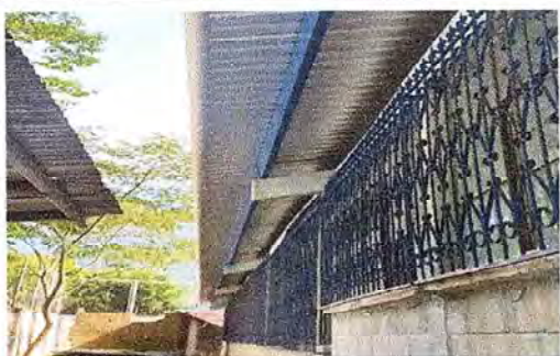
Foto 1: Vista general de la parte de atrás de las aulas con la instalación de láminas troqueladas calibre 26.
