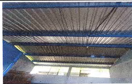
Foto 6: Vista interior de una de las aulas donde presentaba deterioro de las láminas, fueron sustituidas con laminas troqueladas calibre 26.
