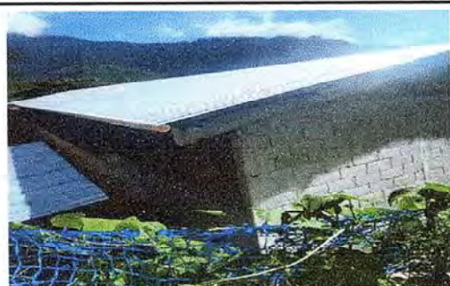
Foto 5: Techado nuevo con la instalación de lámina troqueladas calibre 26 en la parte trasera de la escuela.
